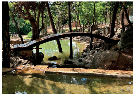
Ponte em construção
